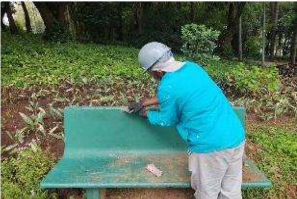
Figura 169: Reforma do banco de concreto
