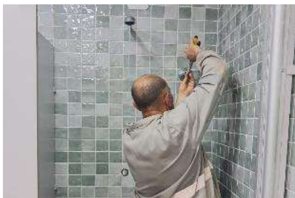
Figura 161: Manutenção de válvulas dos chuveiros
