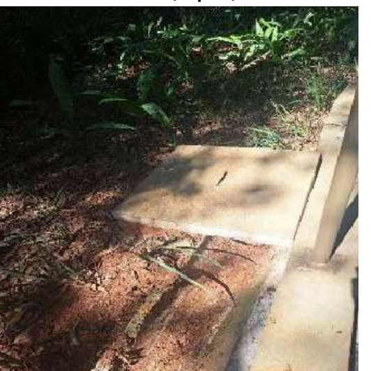
Figura 120: limpeza das calhas com acúmulo de terra (depois)
