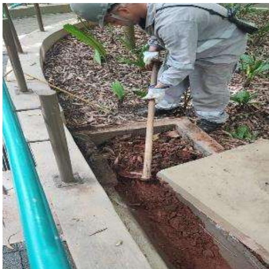
Figura 117: limpeza das calhas com acúmulo de terra e folhas (durante)
