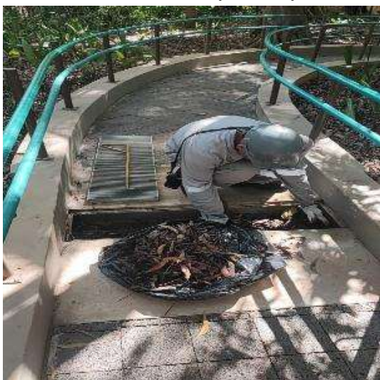
Figura 119: limpeza das calhas com acúmulo de terra (durante)
