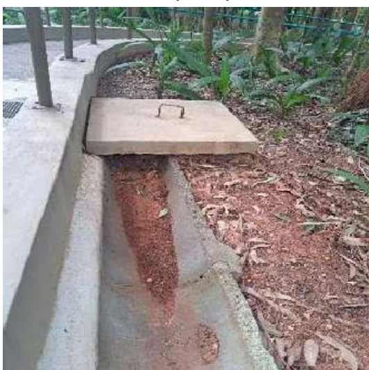
Figura 120: limpeza das calhas com acúmulo de terra (depois)
