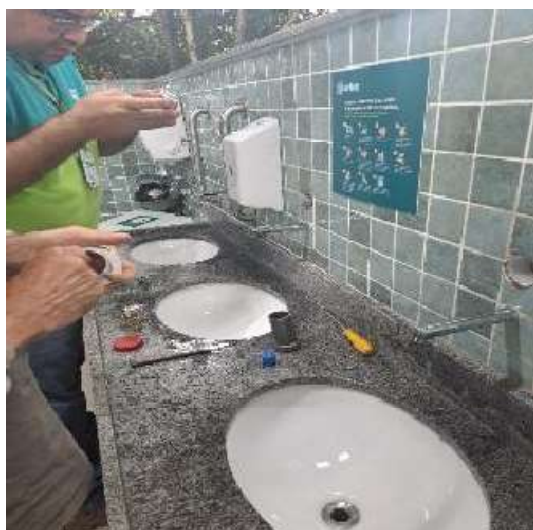
Figura 141: manutenção nas torneiras do lavatório
