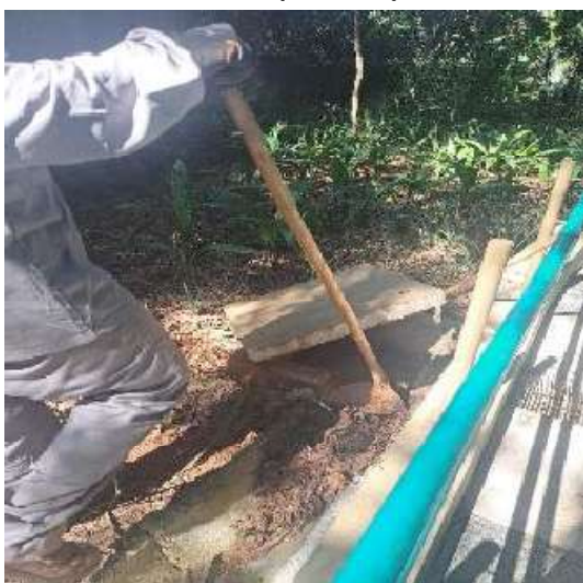
Figura 119: limpeza das calhas com acúmulo de terra (durante)
