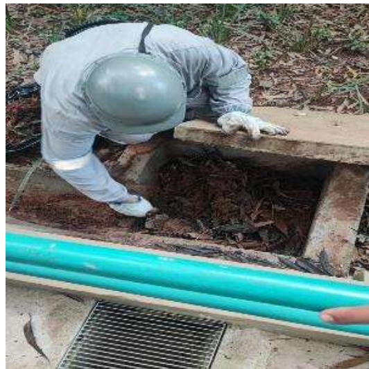
Figura 118: limpeza das calhas com acúmulo de terra (antes)
