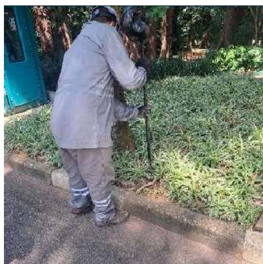
Figura 137: instalação de placas novas (durante)
