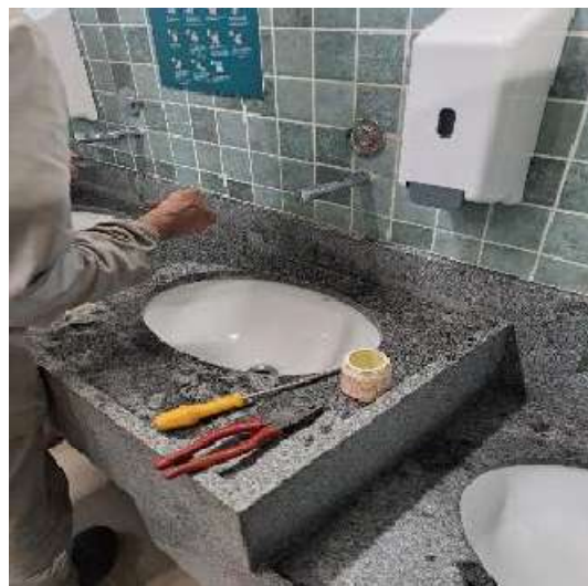
Figura 142: manutenção nas torneiras do lavatório
