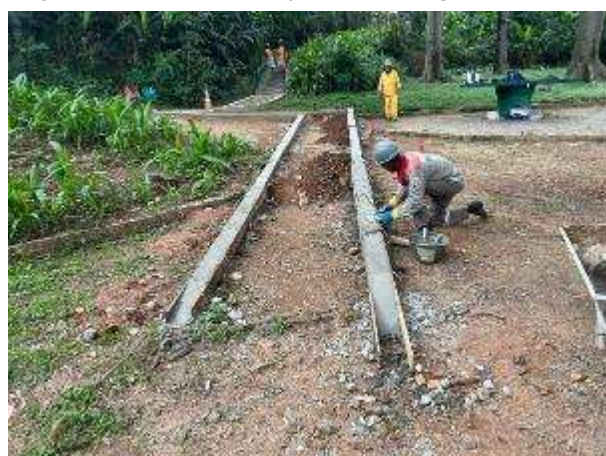
Figura 109: Construção de rampa acessível
