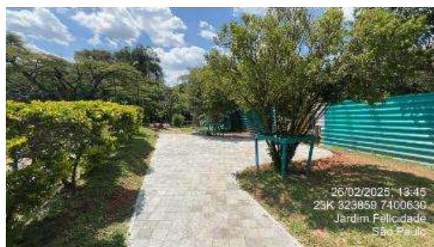
Figura 114: Instalação de piso drenante (Depois)
