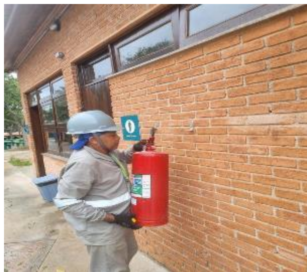
Figura 309: Instalação de extintores
