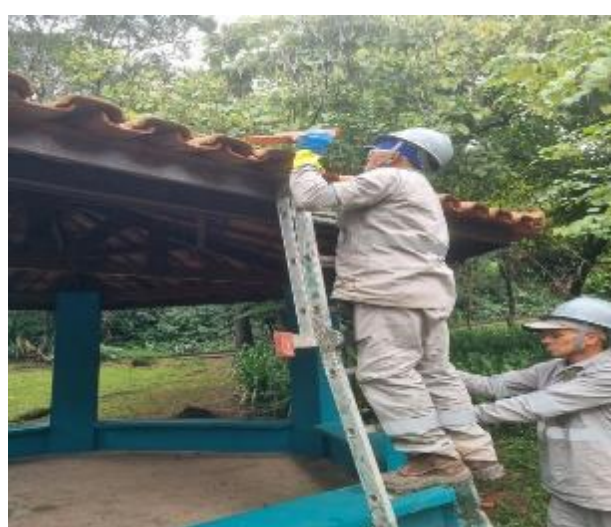
Figura 308: Manutenção do telhado do Quiosque
