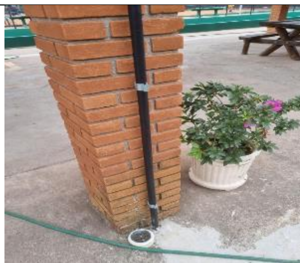
Figura 316: Manutenção de ralo na área do Multiuso
