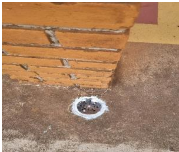
Figura 315: Manutenção de ralo na área do Multiuso
