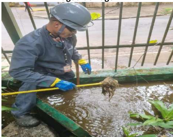
Figura 337: Desentupimento da saída de água do Lago
