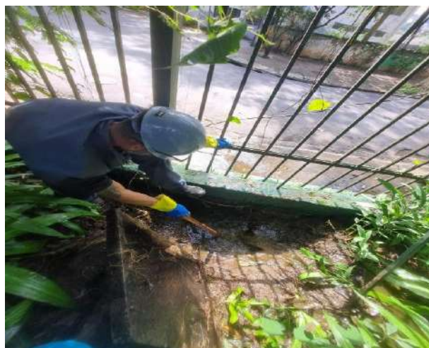
Figura 340: Desentupimento da saída de água do Lago
