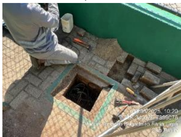
Figura 127 Instalação de ponto de energia quadra
