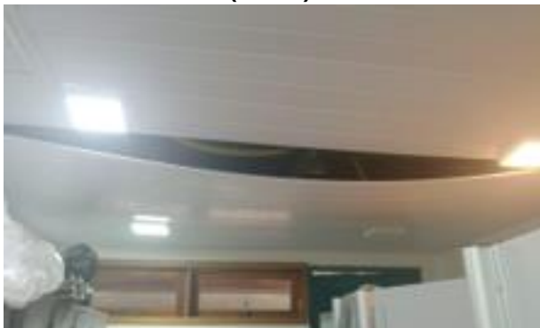
Figura 144 Fixação do forro do vestiário (antes)
