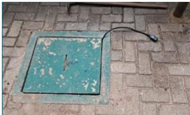
Figura 128 Instalação de ponto de energia
