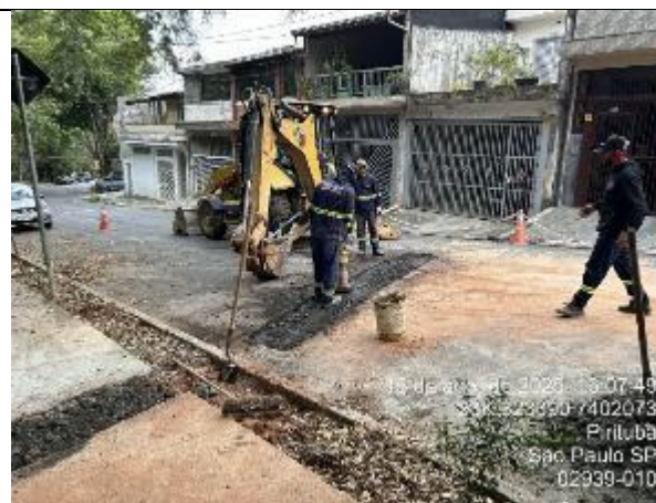
Figura 320: Implantação da rede de esgoto dos banheiros inferiores pela Sabesp
