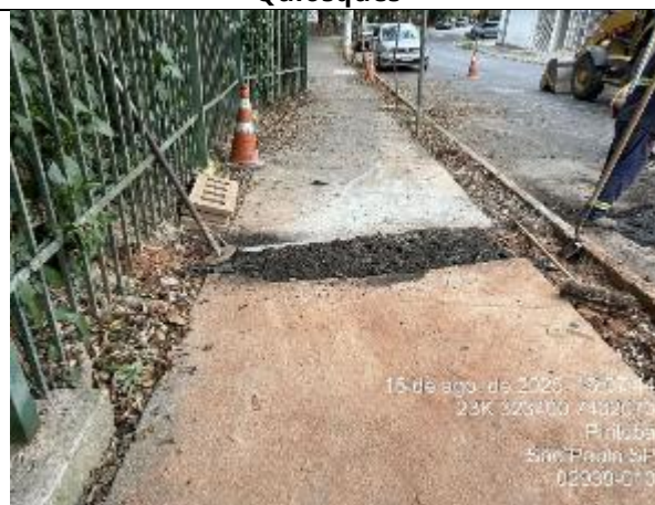
Figura 318: Implantação da rede de esgoto dos banheiros inferiores pela Sabesp
