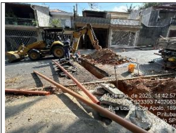
Figura 319: Implantação da rede de esgoto dos banheiros inferiores pela Sabesp
