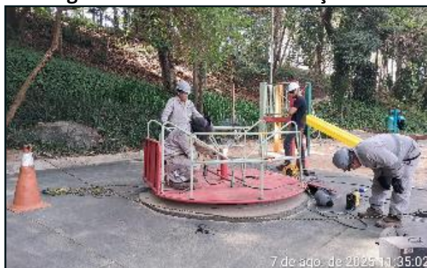
Figura 244 SOLDA EM BALANÇO PCD
