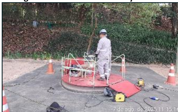
Figura 243 SOLDA EM BALANÇO PCD
