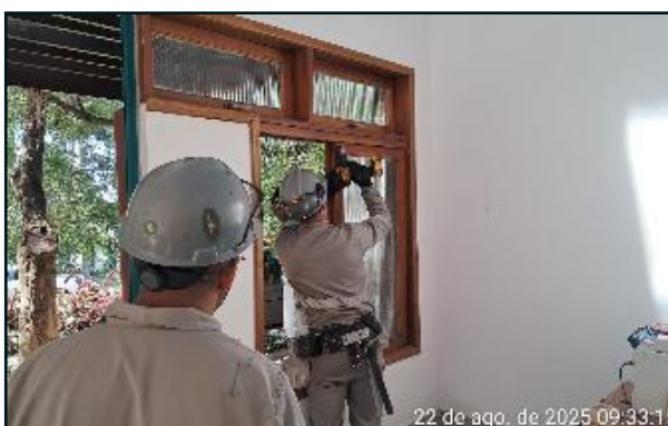
Figura 211 INSTALAÇÃO DE NOVAS JANELAS
