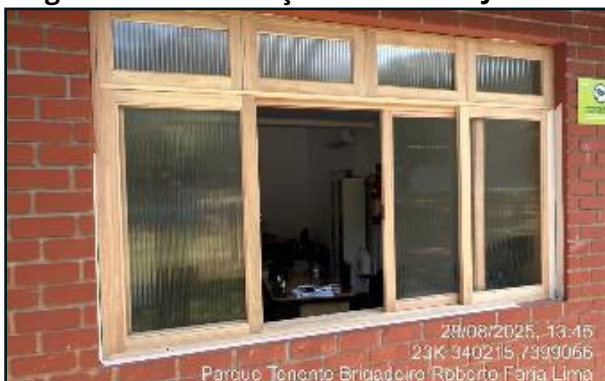
Figura 218 INSTALAÇÃO DE NOVAS JANELAS (DEPOIS)
