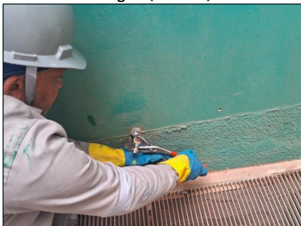
Figura 102; Troca das torneiras da trilha e triagem (durante)
