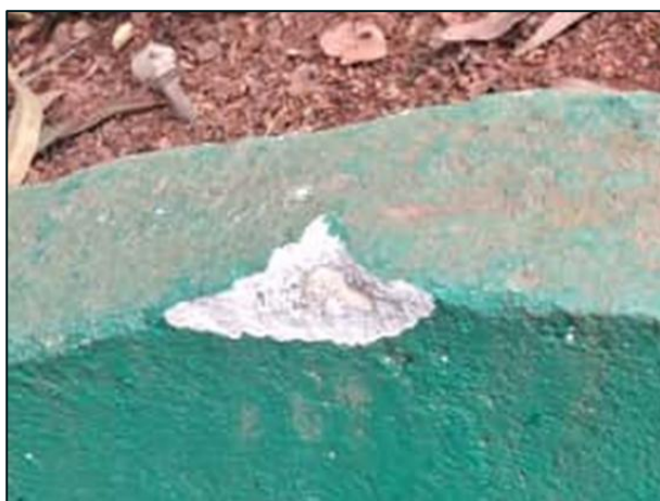
Figura 138: Cobertura de rachadura (antes)
