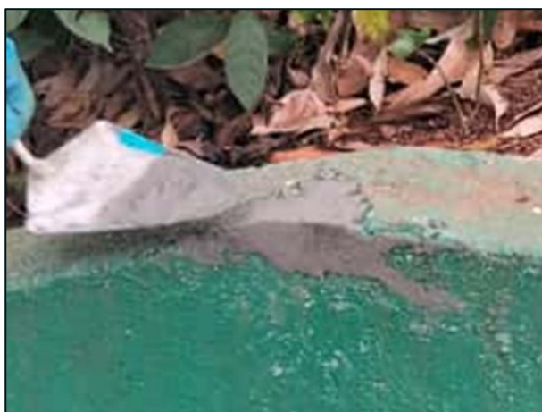
Figura 139: Cobertura de rachadura (durante)
