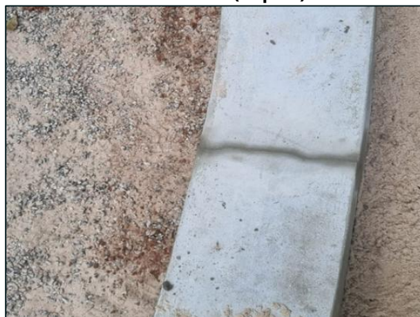
Figura 91: Revestimento na mureta com rachaduras (depois)
