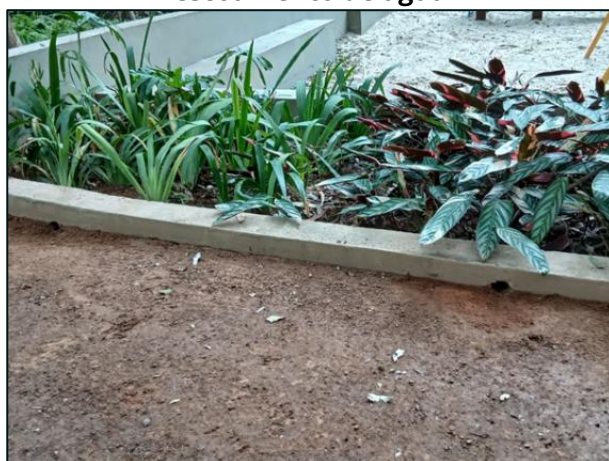
Figura 150: Desentupimento para escoamento de água
