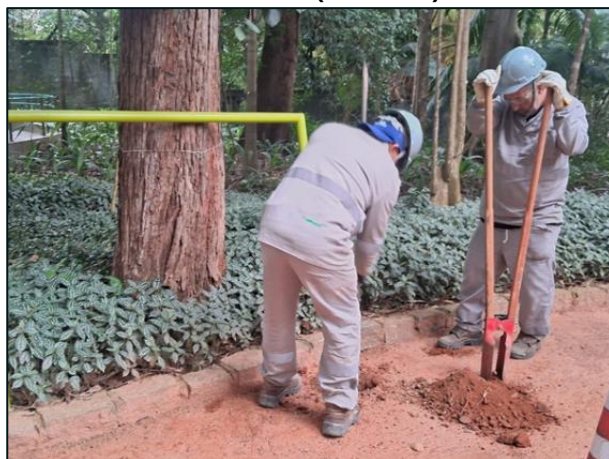
Figura 84: Implantação de barra de apoio na academia (durante)
