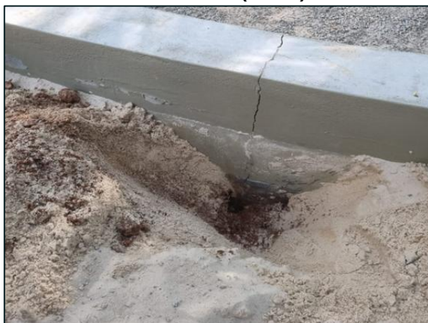
Figura 90: Revestimento na mureta com rachaduras (antes)
