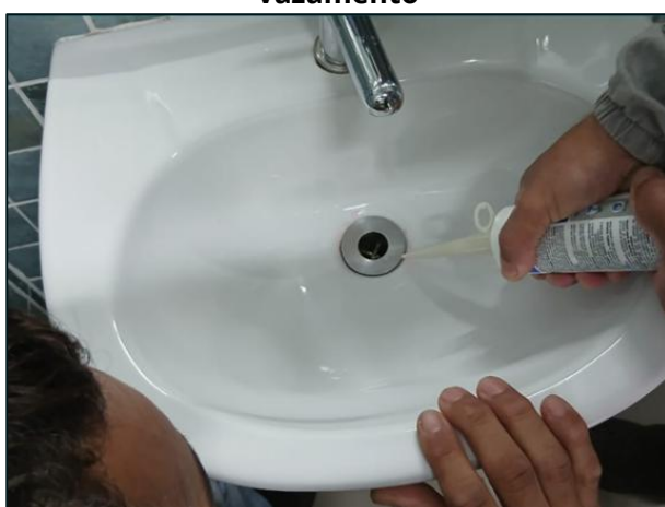
Figura 156: Concerto na cuba que estava com vazamento
