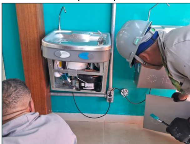
Figura 126: Desentupimento do bebedouro (durante)
