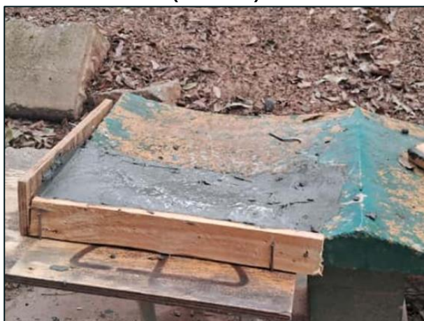
Figura 139: Cobertura de rachadura (durante)
