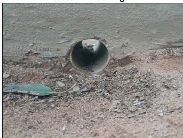
Figura 151: Desentupimento para escoamento de água
