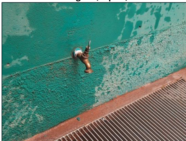
Figura 103: Troca das torneiras da trilha e triagem (depois)
