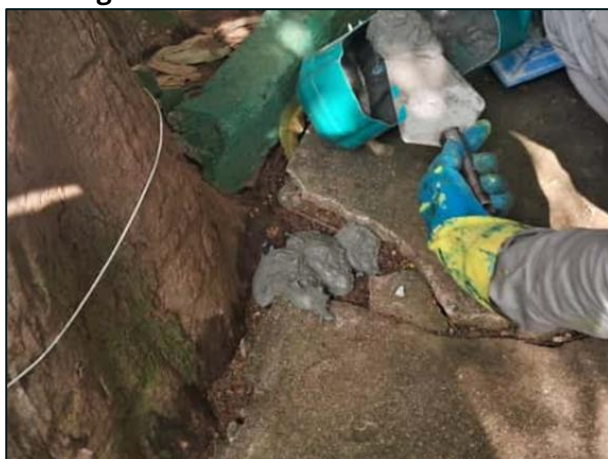
Figura 142: Cobertura de rachadura (antes)
