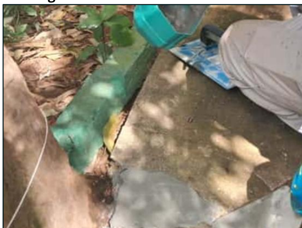
Figura 143: Cobertura de rachadura (depois)
