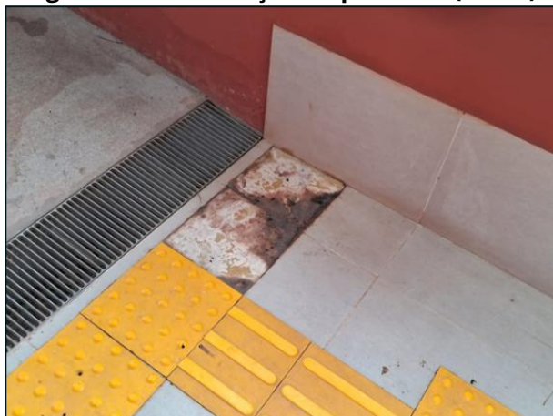
Figura 88: Troca da tampa da válvula de descargas PCDs / Feminino e masculino (antes)
