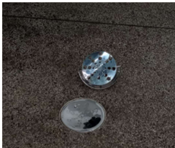
Figura 301: Substituição re ralo danificado
