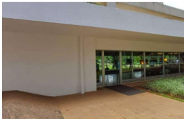
Figura 278: Pintura na fachada EMA
