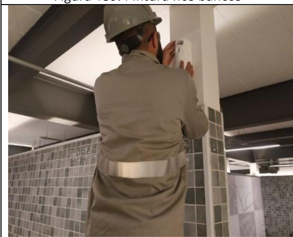
Figura 161: Instalação de insumos nos banheiros
