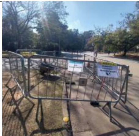
Figura 170: Reparo de pavimentação
