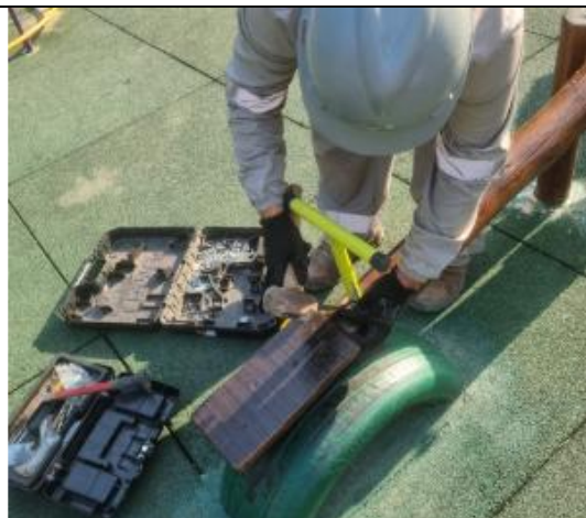
Figura 164: Manutenção dos equipamentos - Playground
