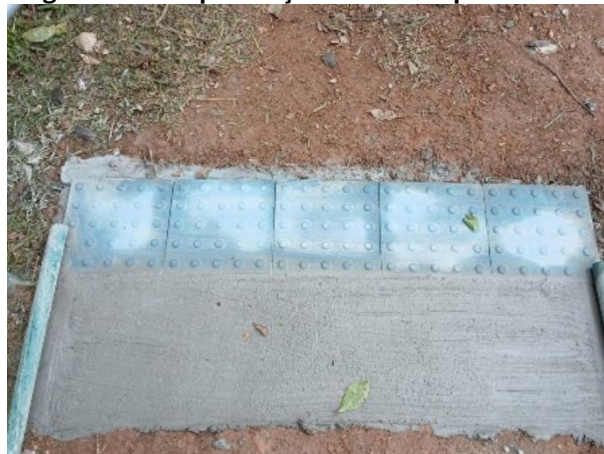
Figura 103: Implantação de novos pisos táteis
