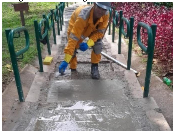
Figura 99: Concretagem da escada caracol
