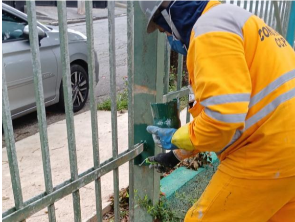
Figura 104: Pintura do gradil
